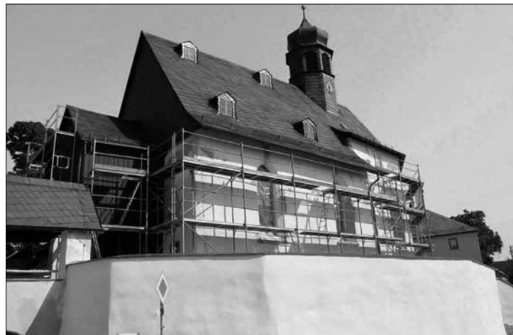
St. Leonhard: hier noch mit Baugerüst und der ebenfalls sanierten Mauer.
