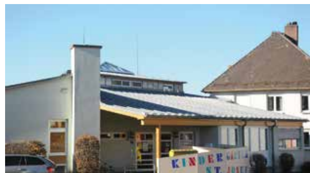
St.-Josef-Kindergarten, Ascher Str. 14 ( catholic kindergarten )
